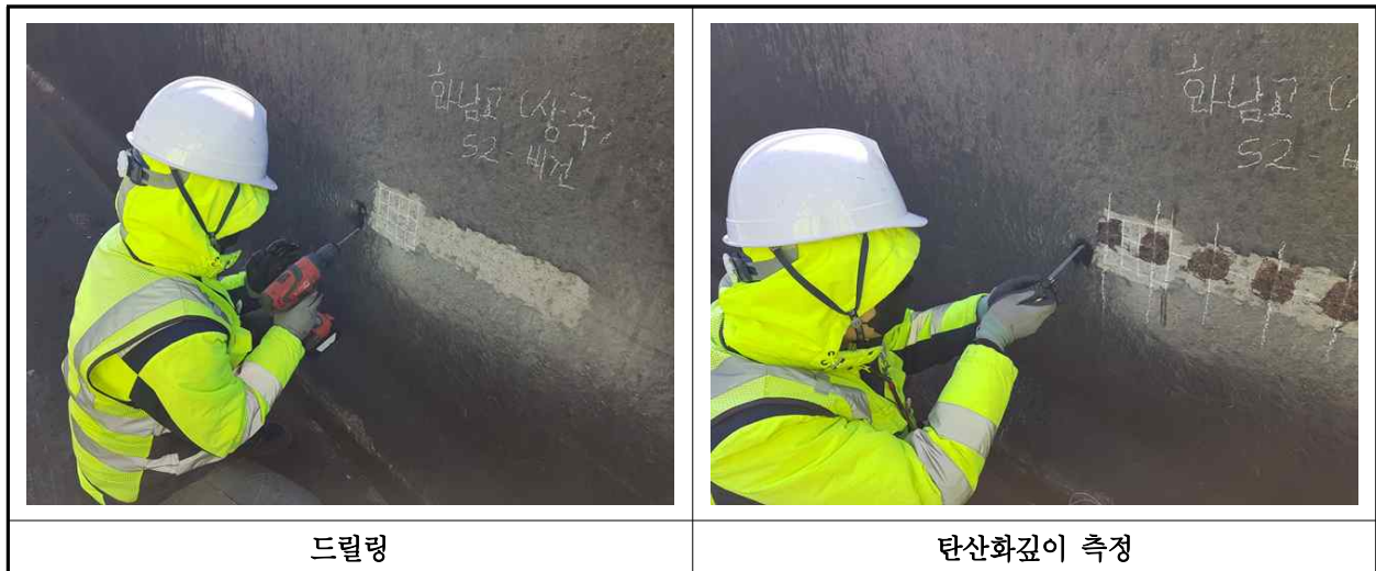
【사진 1.4.3】 탄산화 깊이 측정 현장사진
