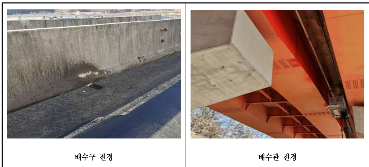
【사진 1.3.6】 배수시설 전경
