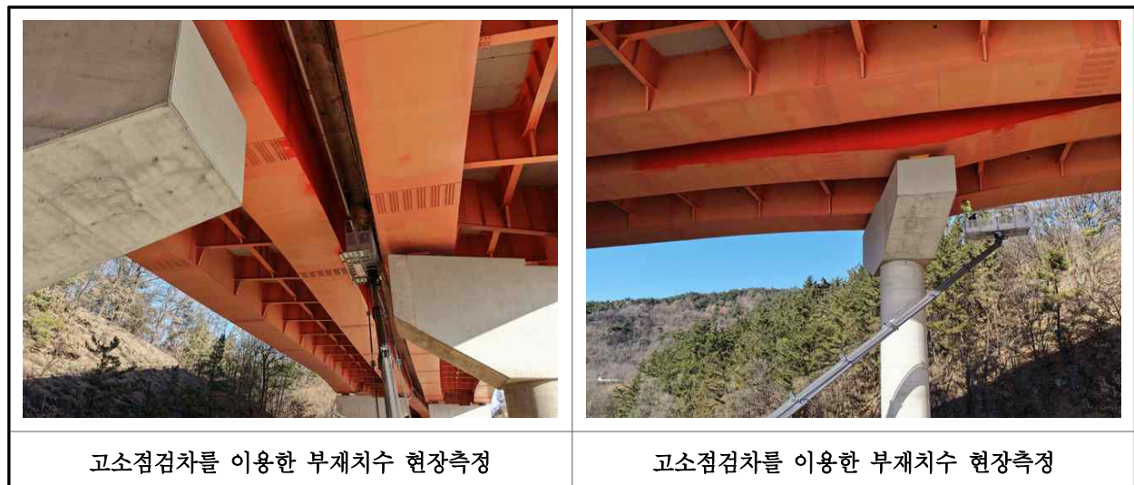
【사진 1.2.1】 부재 현장측정 전경
