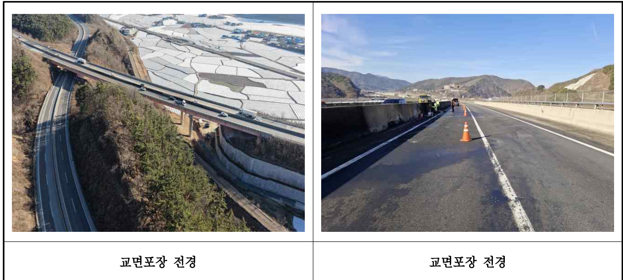
【사진 1.3.4】 교면포장 전경
