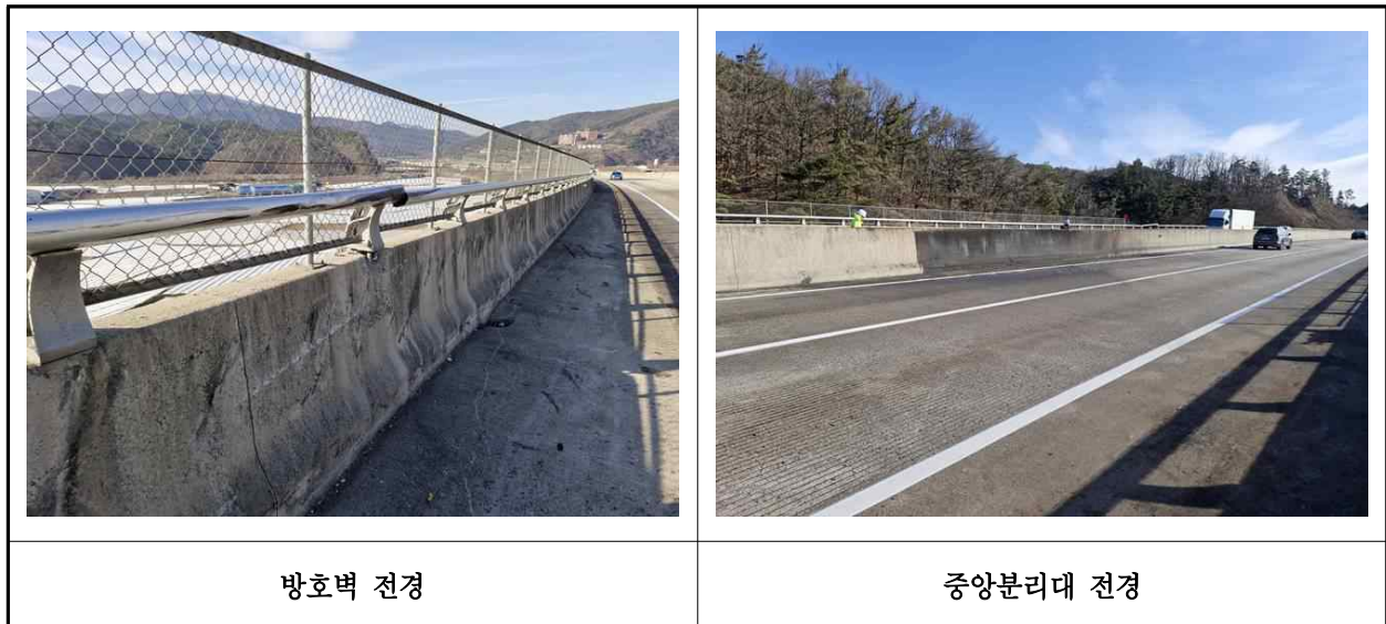
【사진 1.3.16】 방호벽 및 중앙분리대 전경
