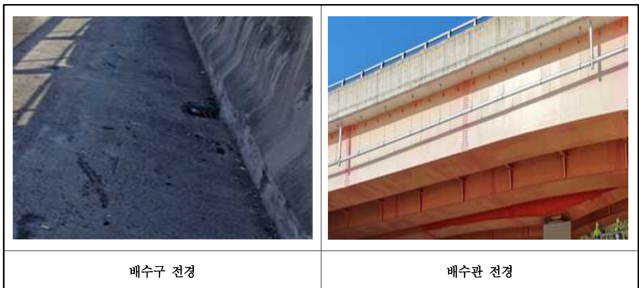
【사진 1.3.14】 배수시설 전경
