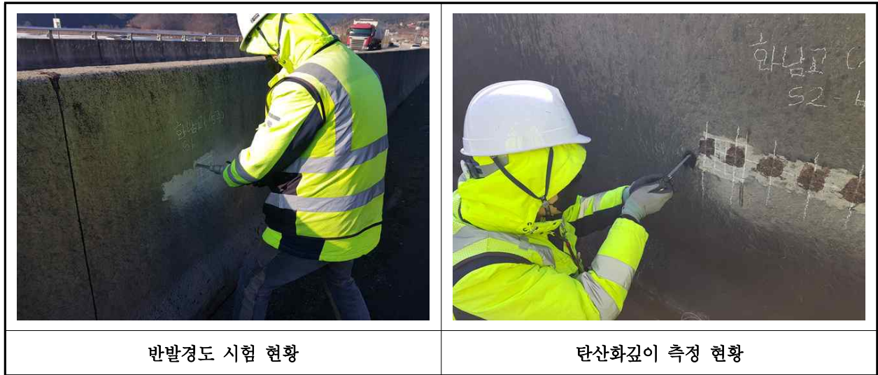
【사진 1.4.1】 콘크리트 내구성조사 현황
