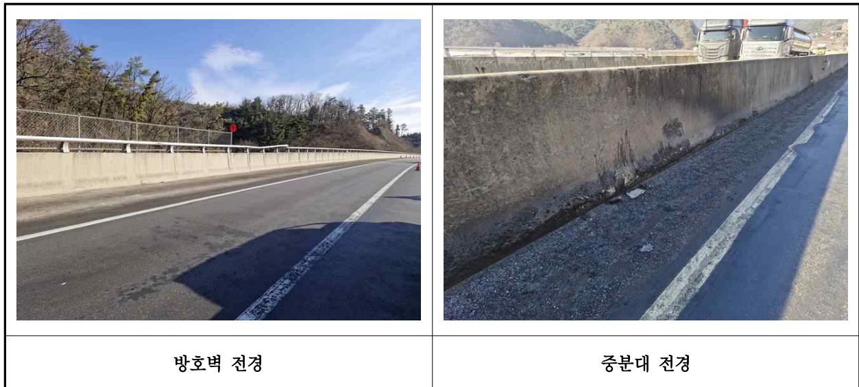
【사진 1.3.8】 방호벽 및 중앙분리대 전경
