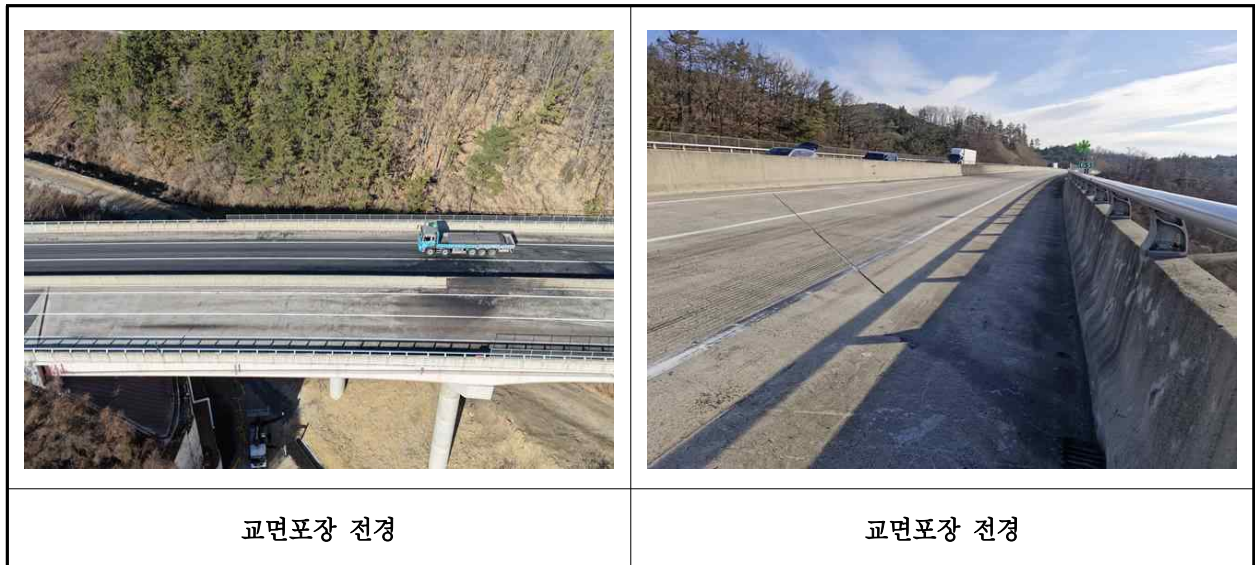
【사진 1.3.12】 교면포장 전경
